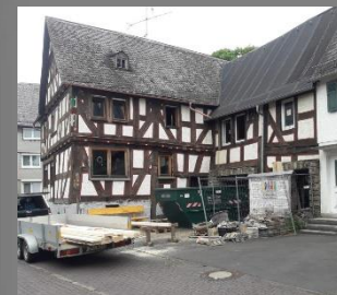
Holzbau am Dachstuhl
